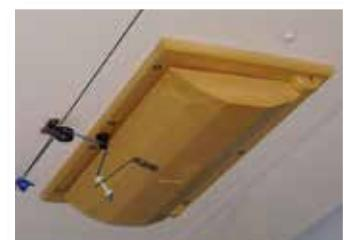
**Wlot sufitowy powietrza z pianki poliuretanowej.**
