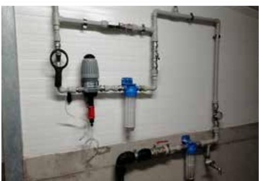
Instalacja wodna w budynku tuczarni – podłączenie poideł i automatów paszowych.
