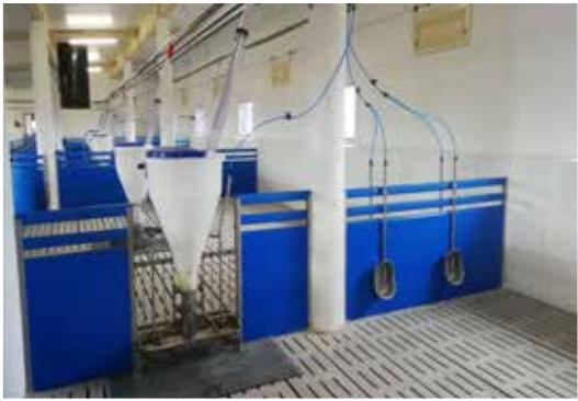
Instalacja wodna na chlewniach wykonywana jest z rur i kształtek PP oraz armatury ze stali nierdzewnej (zawory, śrubunki, nypły). Podłączenie poideł oraz automatów paszowych za pomocą elastycznego węzyka PE.
